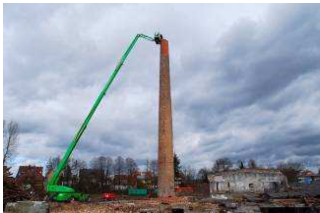
Rückbau Kamin – März 2008
