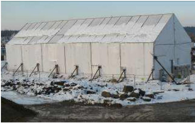
Kyanisierhalle eingehaust – Januar 2009
