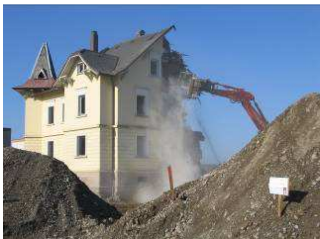
Rückbau „Villa“ – März 2008
